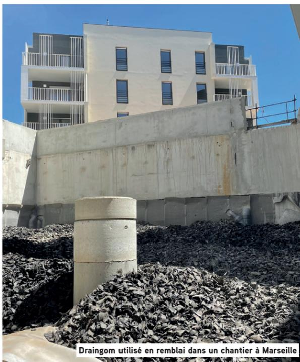
Draingom utilisé en remblai dans un chantier à Marseille
